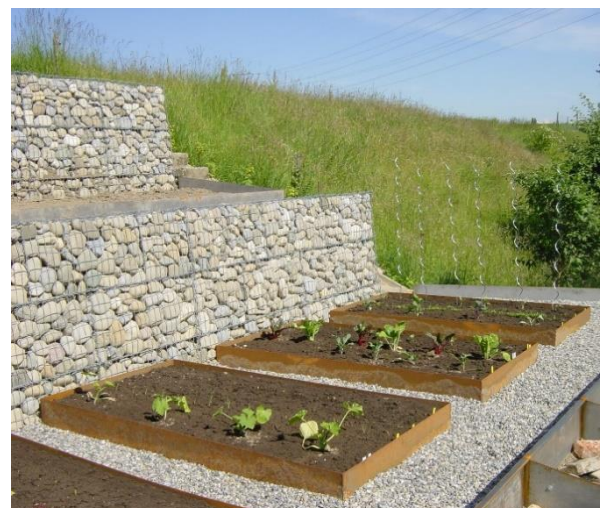
Gartengestaltung mit Drahtschotterkörben 1
