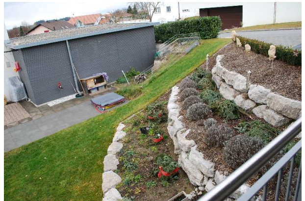
Terrassierung einer Böschung mit Blocksteinmauer
