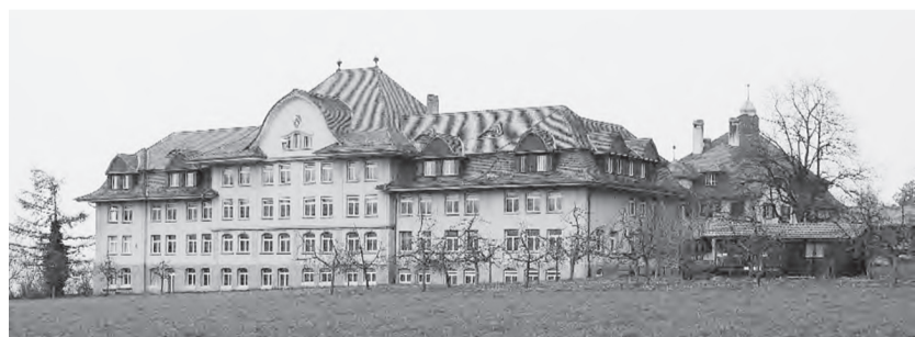
Seitenansicht Hauptgebäude Landwirtschaftliche Schule Schwand, Münsingen (Baujahr 1912–1914).
