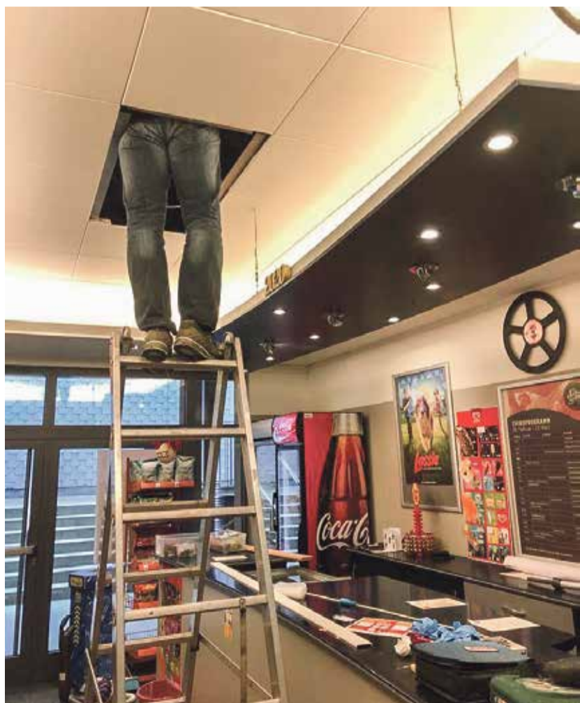
Die Kabel für die Automatisierung werden von Daniel Tschanz neu verlegt. Bild: zvg
