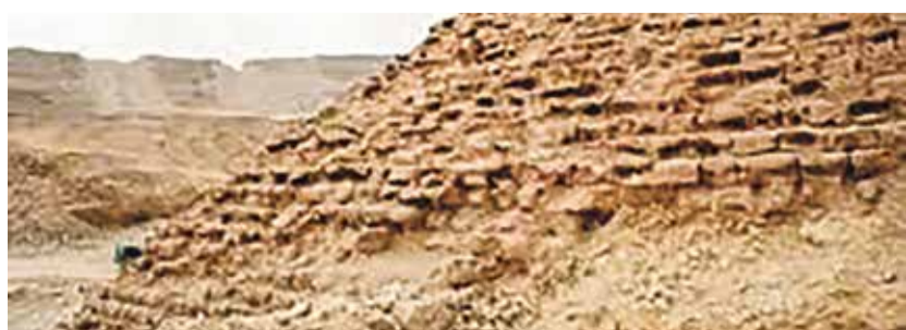
Die Talssperre von Sadd-el-Kafara in Ägypten (2600–2500 v. Chr.) ist eines der ältesten Wasserbauwerke der Welt und diente dem Hochwasserschutz und der Bewässerung. Mit einer Dammhöhe von 14 m und einer Dammkrone von 113 m staute es auf 185 km 2 bis gegen 620 000 Kubikmeter Wasser. Bild: Wikipedia
