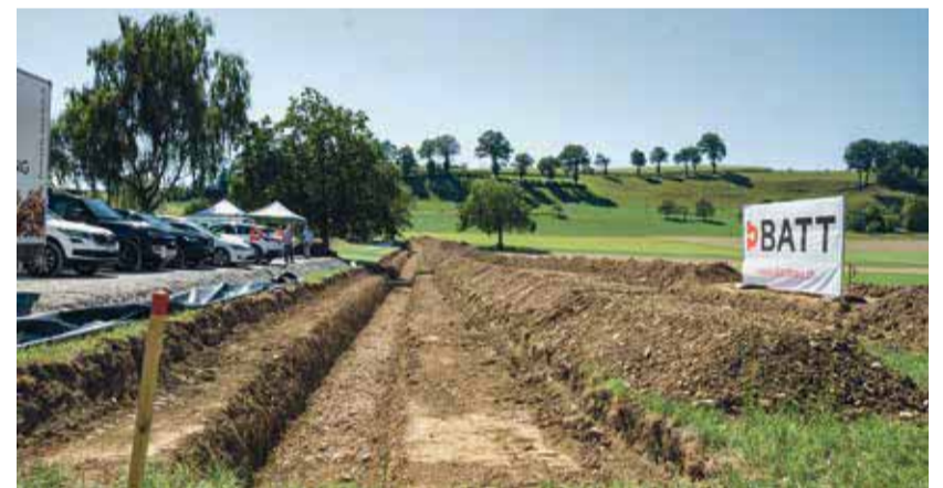
Die Baustelle am Toggenbühlweg.
