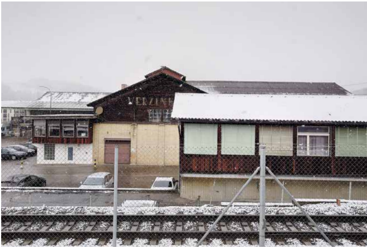
Auch auf dem Areal der Verzinkerei kommt die Abrissbirne zum Einsatz.
