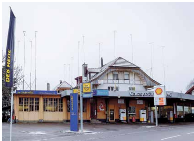
Muss bald einer neuen Überbauung weichen: die Garage Sägesser
