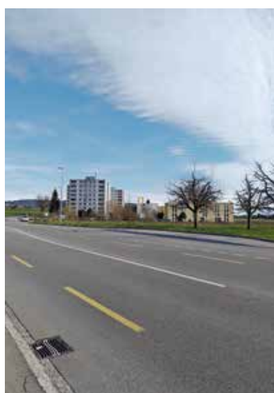
Hier starten schon bald Bauarbeiten.
