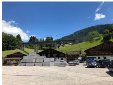
Baustelle am Montag...
