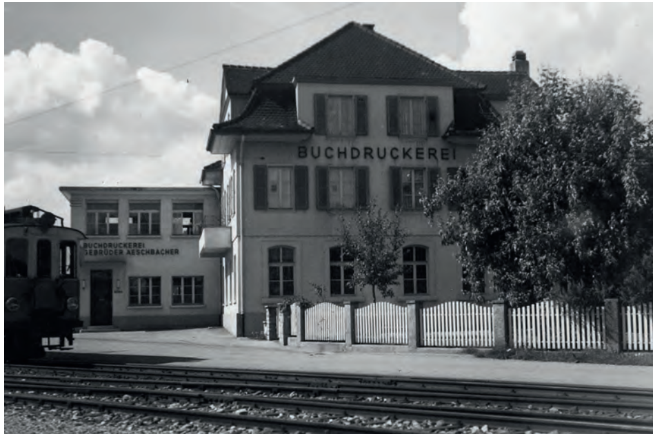
Druckereigebäude an der Güterstrasse
