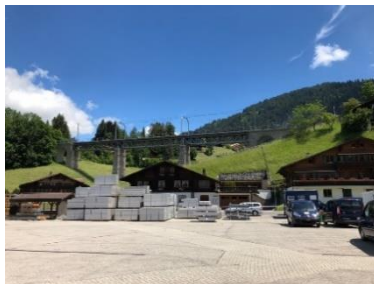
Baustelle am Montag...
