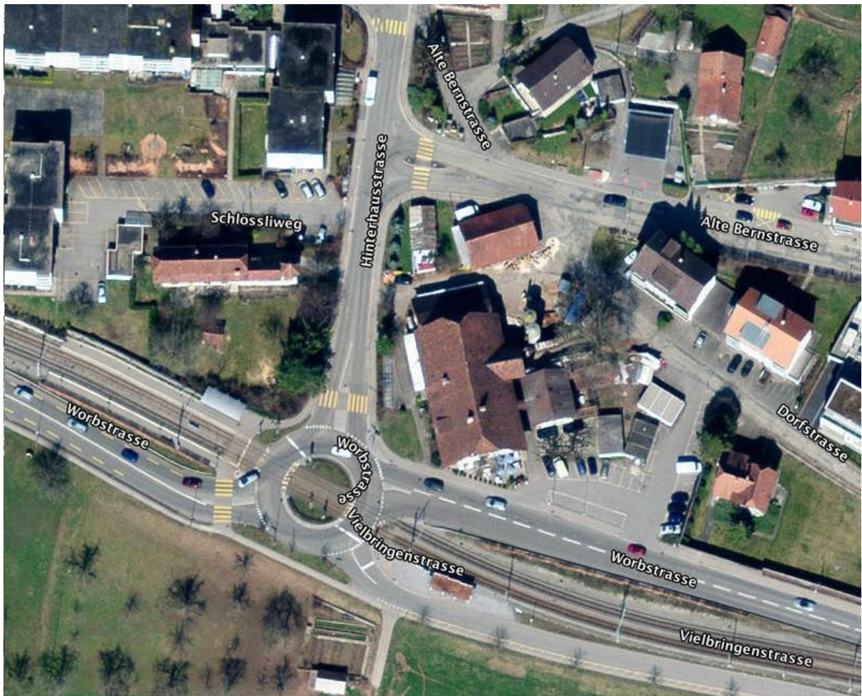
Abbildung 4: Das «Restaurant Zur Sonne» am Durchgangsverkehr und am Kreisel
