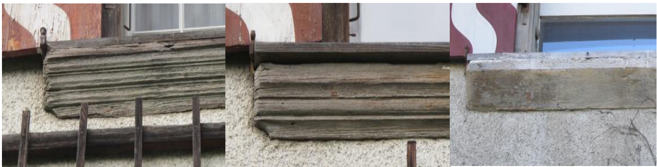
Abb. 29a–c: Unterschiedliche Fensterbänke im Obergeschoss
