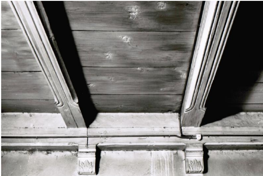
Abb. 31: Bern, ehemals Marktgasse 42 Balkendecke mit Schiffchenprofil, 1596 Foto 1956
