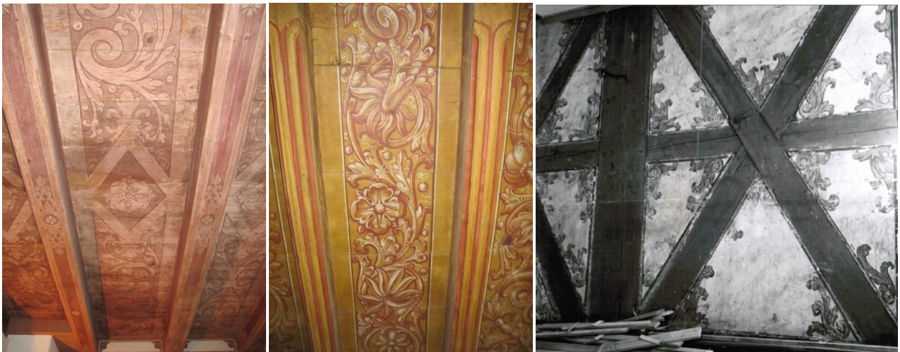
Abb. 24: Obergeschoss Ost ländliche Deckenmalerei, 18.Jh., Zustand heute
