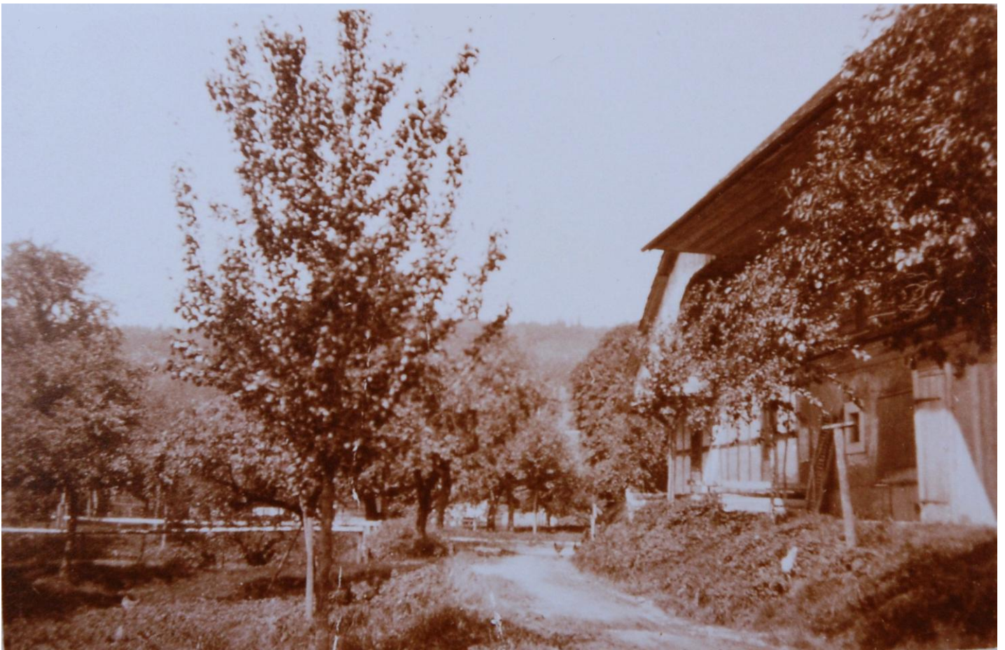
Abbildung 18: Die Einfahrt in das Dorf Rüfenacht beim Bauernhaus und Gasthof «Zur Sonne» um 1950. Die neue Dorfeinfahrt als schmaler Bauernweg ohne Belag längs der «Sonne», linkerhand der Obstgarten des Landsitzes, an dessen Stelle heute die breite Hinterhausstrasse verläuft.
