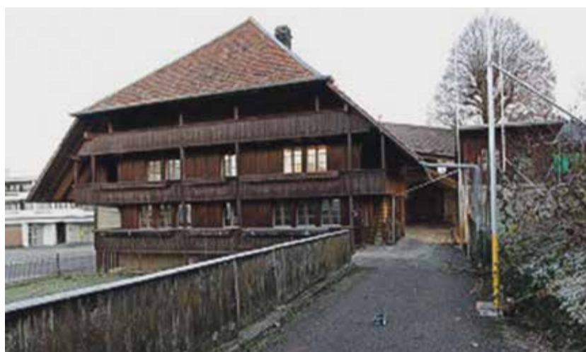
Abb. 1. Die Fassade des Aebersoldhauses (Baujahr 1740) in Rüfenacht wurde in den 1980er Jahren erneuert. Blick nach Norden.
