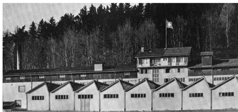
Die 1938 eingeweihte Filzfabrik in Enggstein mit dem Sheddach (um 1955). Die schräg gestellten und verglasten Dächer erlauben einen maximalen Lichteinfall in die Produktionshalle (IG Worber Geschichte, Bilddatenbank, Foto Ernst Aebi).
