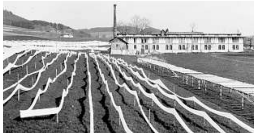
Bleicherei in Worb in der ersten Hälfte des 20. Jahrhunderts. Markant stehen die bei der Fabrik ausgelegten Leinwandbahnen hervor. Die Tücher wurden grossflächig und weithin sichtbar ausgelegt, um das Leintuch, von Natur aus grau, im Sonnenlicht zu bleichen.
