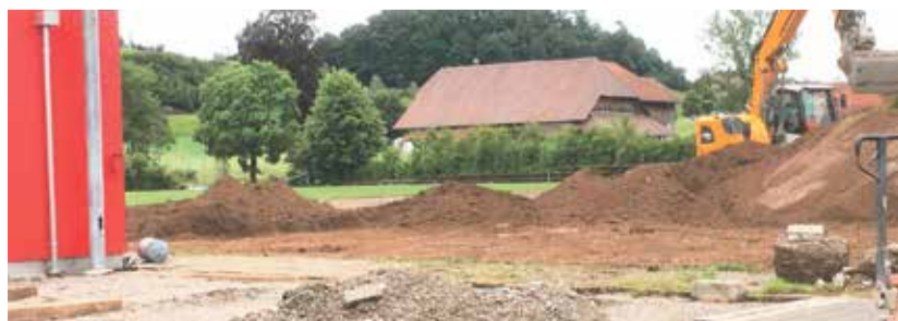
Kunstrasen-Baustelle im Worboden.
