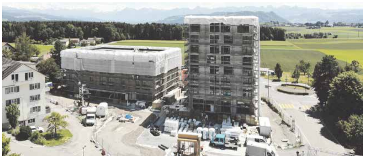
Die ersten Arbeiten für den neuen Dorfplatz beginnen schon bald.
