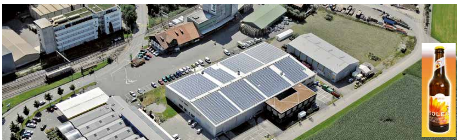
Grosse Photovoltaikanlage der KWT Kälte-Wärmetechnik AG in Worb SBB
