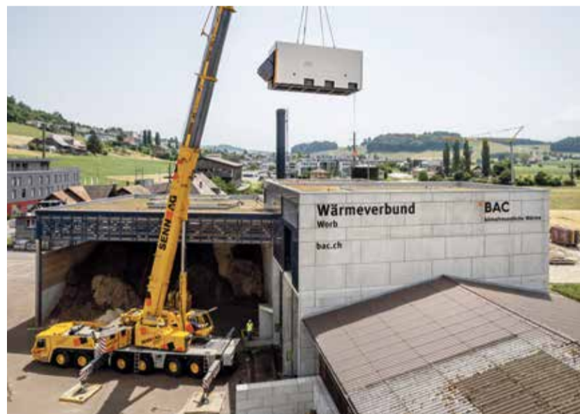
Erweiterung der Heizkapazität: Mittels Spezialkran wird der zusätzliche Holzheizkessel ins Gebäude eingebracht.
