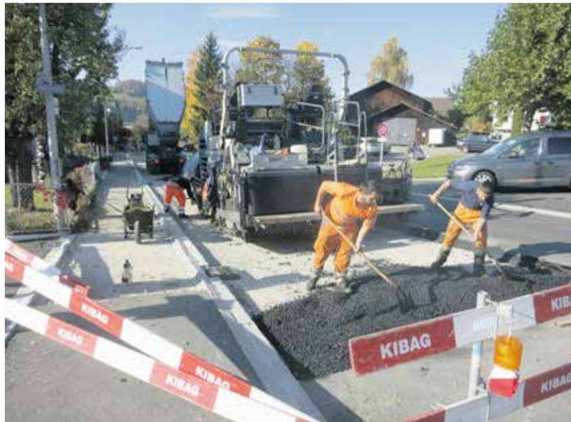
Der Belageinbau auf der Bollstrasse bildet den Abschluss der Sanierungs- arbeiten. Bild: OIK II
