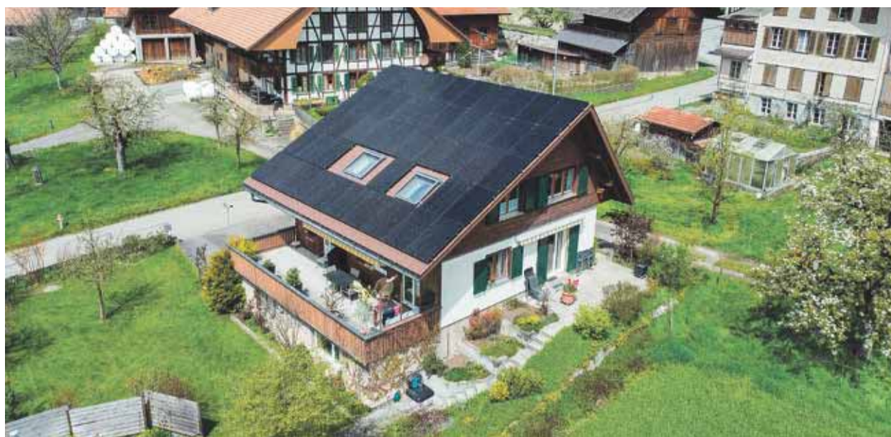
Photovoltaik-Anlage auf einem Richiger Hausdach.
