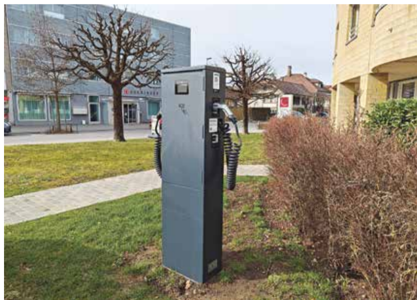
Die neue Ladestation ist ab 1. März einsatzbereit.
