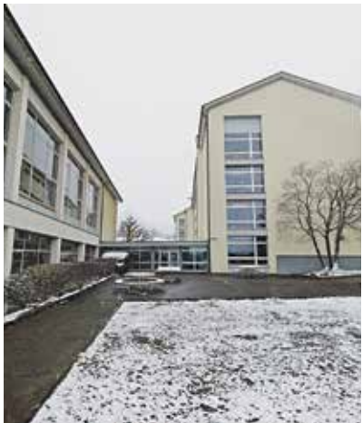
Ab 2026 wird der Notfalltreffpunkt vorübergehend ins Schulhaus Wyden verlegt. Bild: AW
