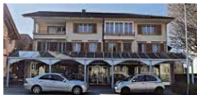
Hier werden Alterswohnungen entstehen. Bild: AW
