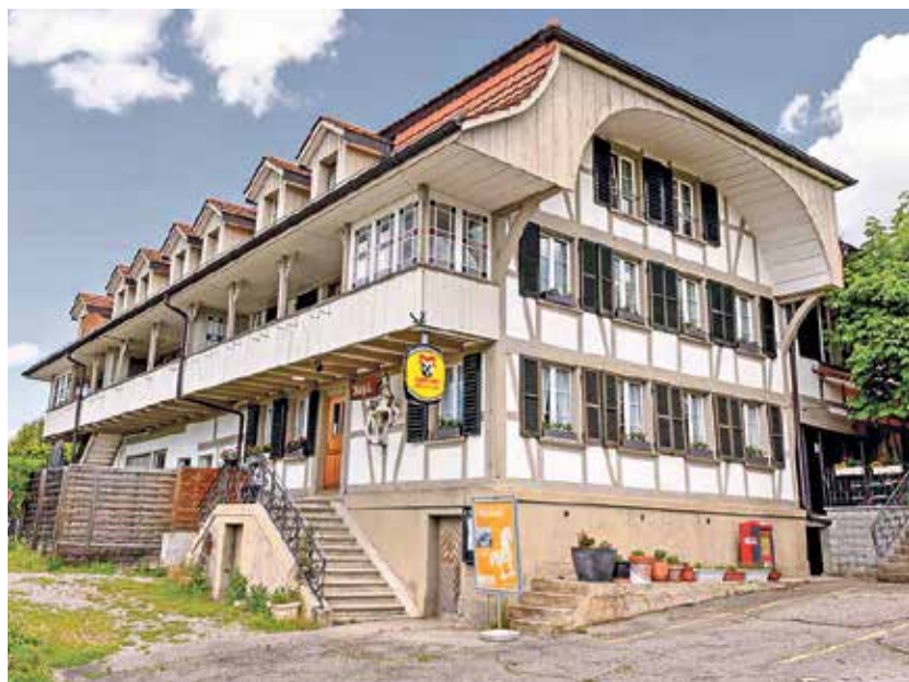
Primär werden im Rössli Wohnungen gebaut.
