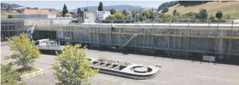
Turnhalle und Aula sind eingerüstet. Bild: zvg
